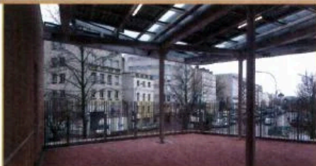
L'école Pef à Saint-Ouen (Seine-Saint-Denis), préau sous les panneaux photovoltaïques. Mikou Design Studio. Ph. © Gwenaël Querrien.
