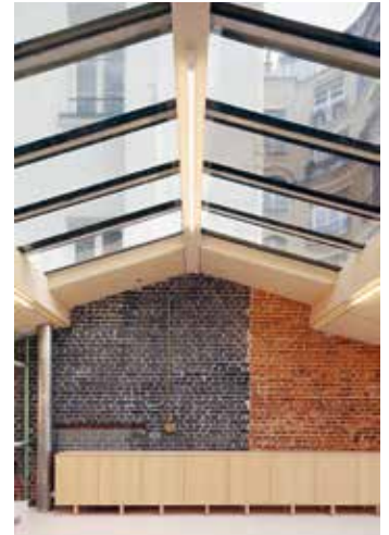
Renovierung des Atelier Campagne Première, Paris Renovation, Atelier Campagne Première, Paris
